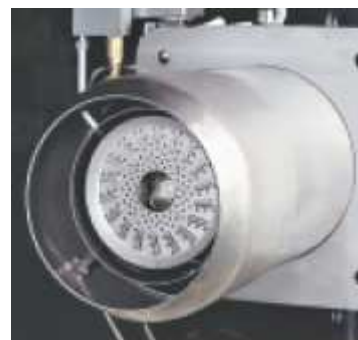
Příklad spalovací hlavy hořáků MODUBLOC MB LE
