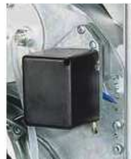
Mechanismus otevírání vzduchové klapky
