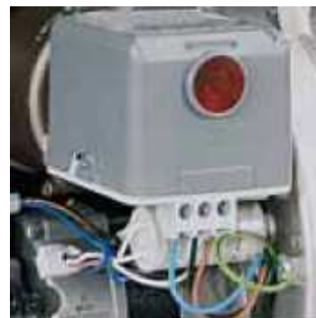
Automatika se zapalovacím transformátorem
