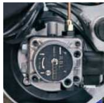
Palivové čerpadlo
