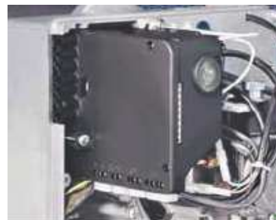
Automatika se zapalovacím transformátorem
